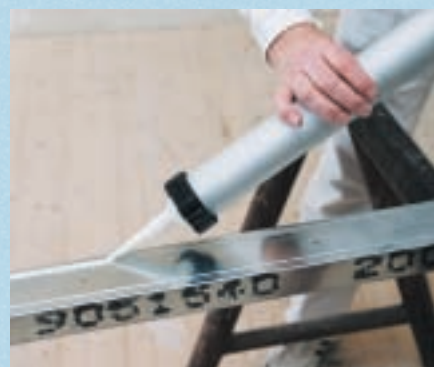
Knauf Trennwandkitt az UW profil hátoldalán
