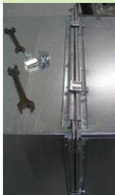
A peremek kerámiaszalag tömitésével és tűzálló ragasztással, acélpántokkal összefogatva
