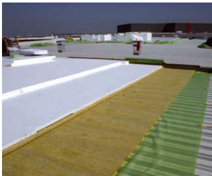
Példa az SG COMBIROOF 30M rendszer alkalmazására egy logisztikai központ tetőjének építésénél.
